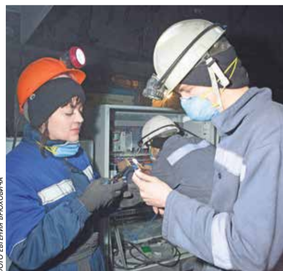
Наталию Вайлердт обучают опрессовке кабеля
