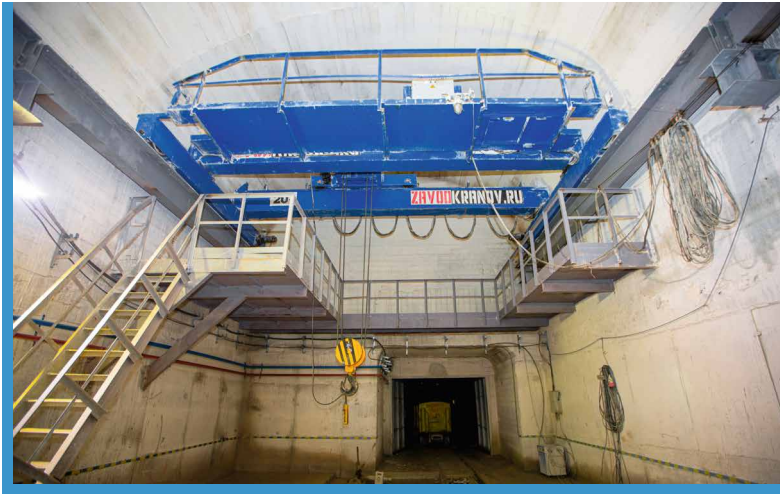
Вагоноремонтное депо горизонта - 250 м.
