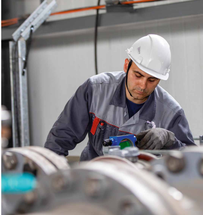
Техник КИП Денис Новиков подключает расходомеры и плотномеры к системе автоматизации насосной.
