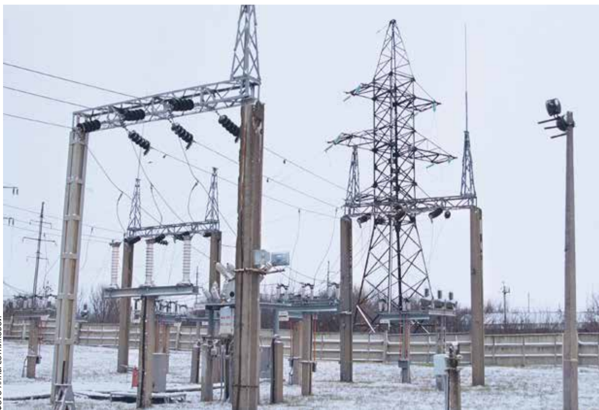
Открытое распределительное устройство 35 кВт
