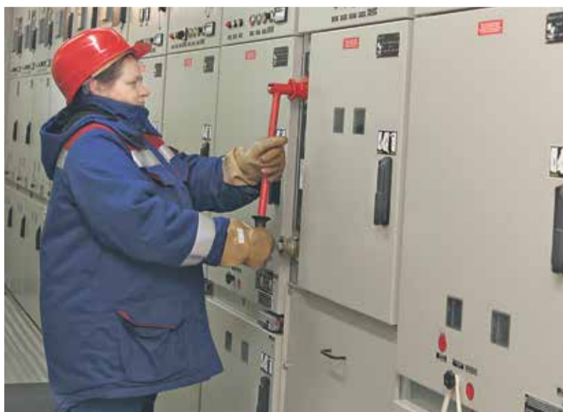
Наталья Макарова включает заземляющие ножи высоковольтной ячейки
